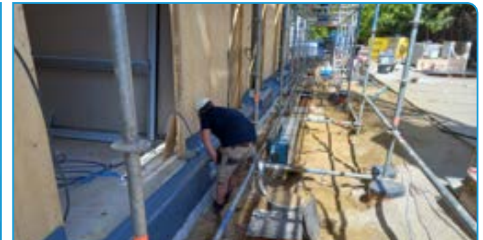
RAKENNUSTEN PERUSTUSTEN VEDENERISTYS AQUAPROOF REACTIVELLA
