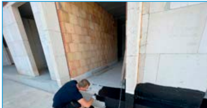
RAKENNUSTEN PERUSTUSTEN VEDENERISTYS AQUAPROOF REACTIVELLA
