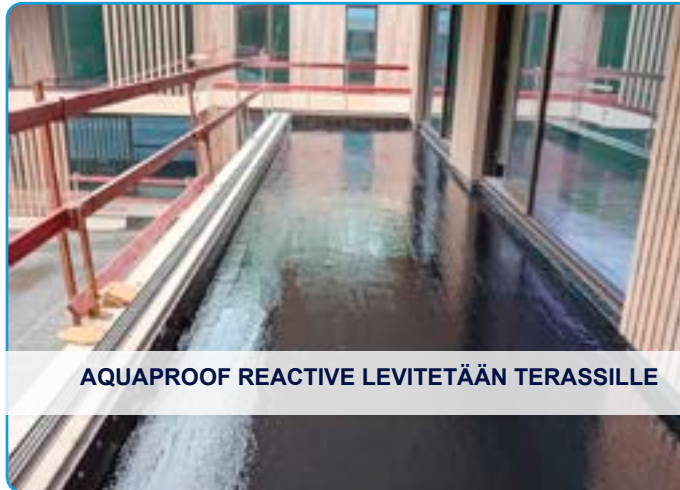
AQUAPROOF REACTIVE LEVITETÄÄN PARVEKKEELLE
