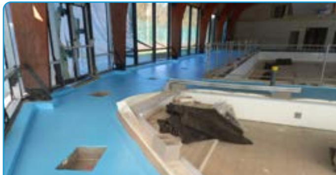
VEDENERISTYS ENNEN LAATOITUSTA UIMA-ALTAAN YMPÄRILLÄ
