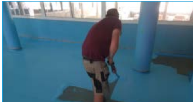
VEDENERISTYS MÄRKÄTILOJEN LAATOITUKSEN ALLA
