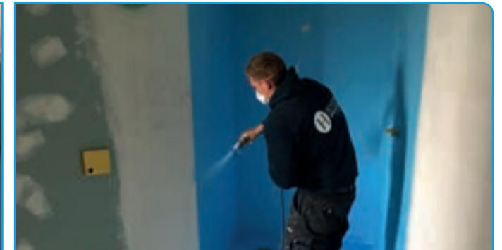
VEDENERISTYS SUIHKUJEN LAATOITUKSEN ALLA
