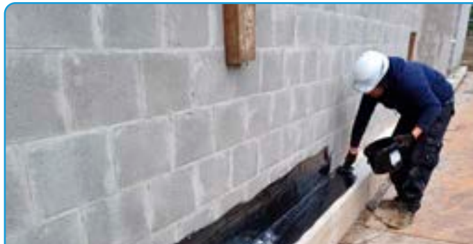
RAKENNUSTEN PERUSTUSTEN VEDENERISTYS AQUAPROOF REACTIVELLA
