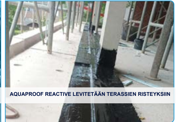
AQUAPROOF REACTIVE LEVITETÄÄN PARVEKKEELLE
