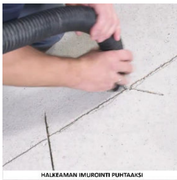
HALKEAMAN IMUROINTI PUHTAAKSI
